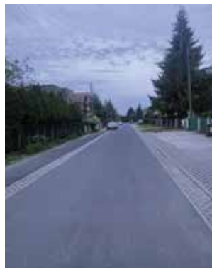
Wyremontowany fragment ulicy Nałęczowskiej
