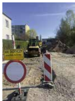
Budowa dojazdu do bloków ul. Raczyńskiego
