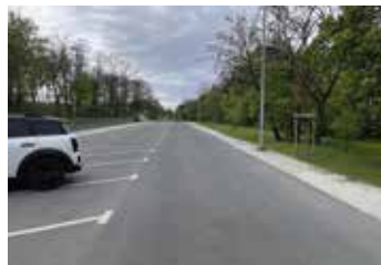
Parking przy cmentarzu na ul. Lutyckiej
