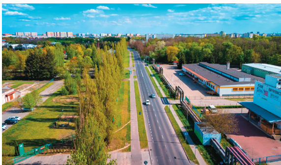
Remont ul. Strzeszyńskiej
