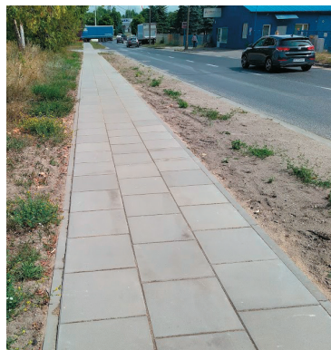
Remont chodnika przy ul. Szarych Szeregów
