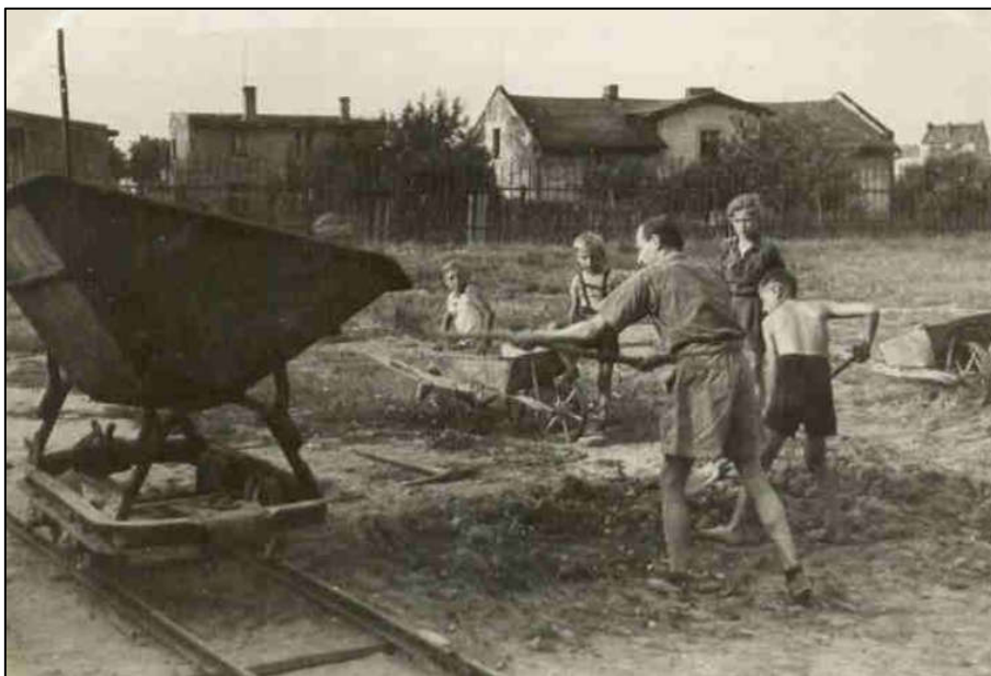
Fot. 12. Harcerze niwelują teren pod budowę Domu Harcerza. W tle dom rodzinny dh Teodora Krügera na ul. Bonin.
